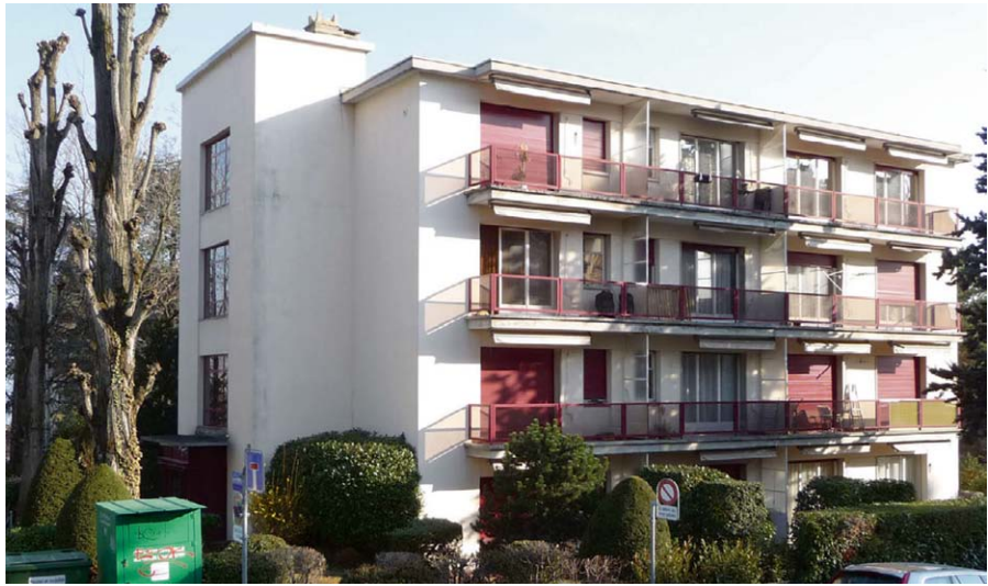
Photo avant travaux
